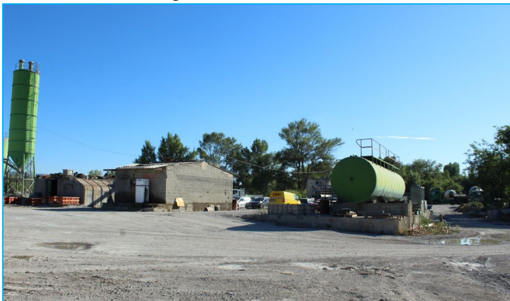
Figure 4 : station-service du site
