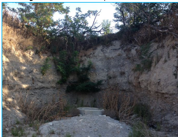
Figure 16 : état actuel du puits de la carrière
